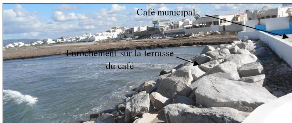
**Photo1.** L'invasion sévère des dunes bordières, a provoqué leur déstabilisation et le démaigrissement de la plage. À Soliman-Plage (à l'ouest de la sebkhha de Soliman), en face du café municipal, la plage a totalement disparu; des enrochements et brise-lames prennent place pour réduire l'effet des vagues, [cliché : Noura BRAHMI, automne, 2015]
